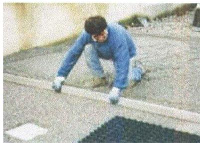
Fig. 2 Staggiatura e preparazione del fondo.
